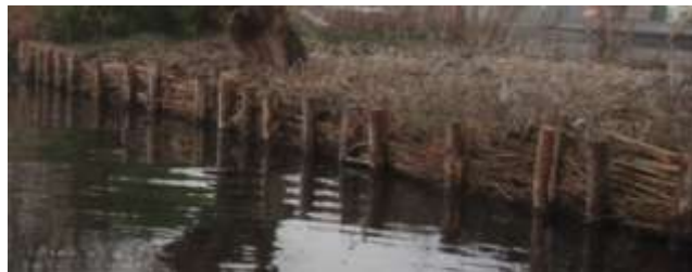
Beschoeiing met wilgentenen geeft de vis extra schuilmogelijkheden
